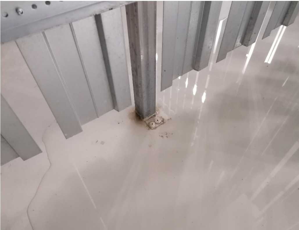
Abb. 13 Pfützenbildung im Übergangsbereich der Flurfläche zu einem offenen Kellerabteil
