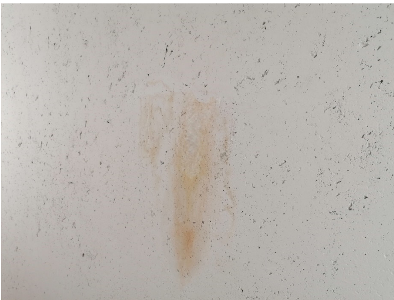
Abb. 3 Korrosionsspuren durch Ausschwemmungen als Folge vergangener Wassereintritte
