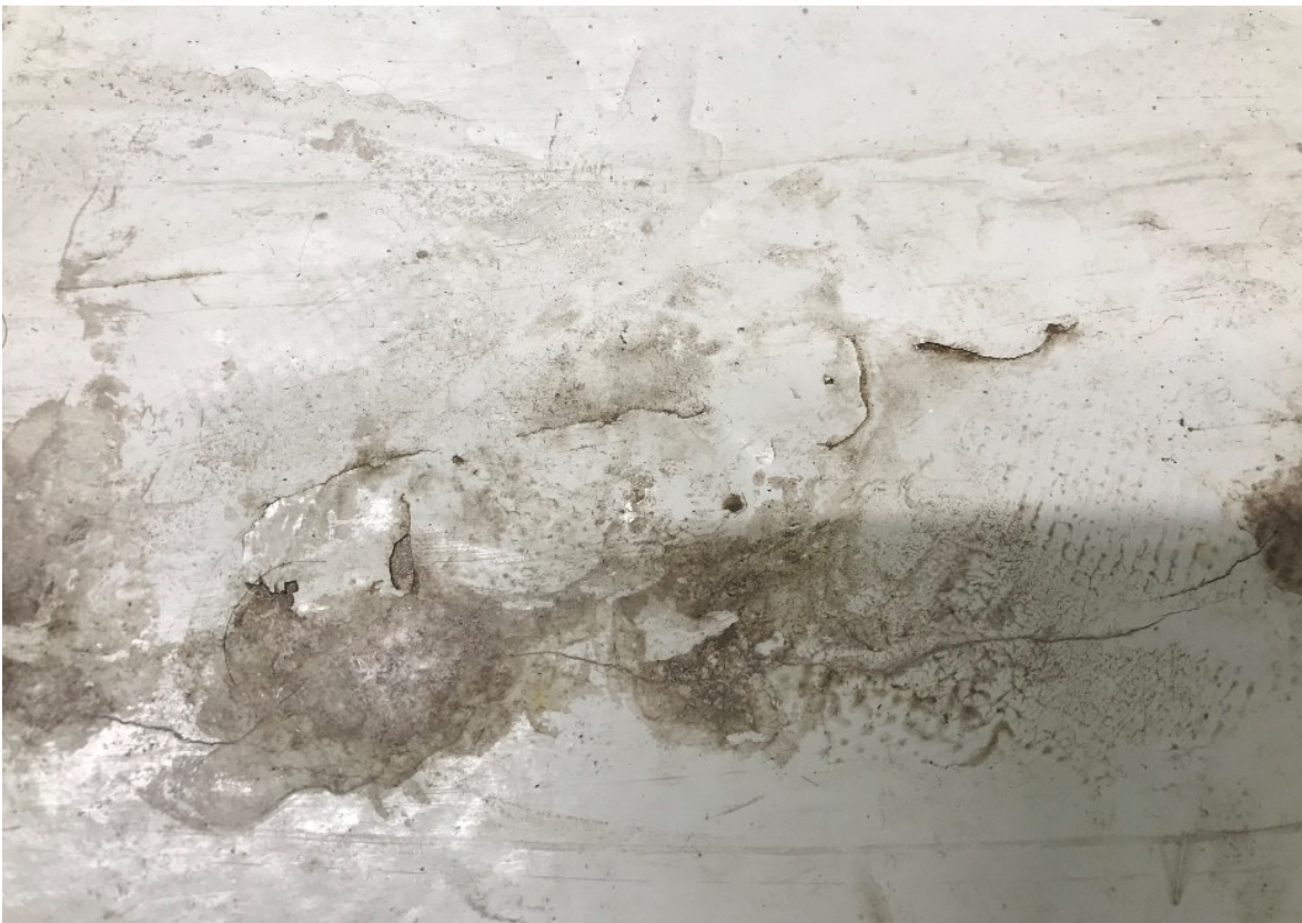
Abb. 21 Abplatzungen und Blasenbildungen in der Beschichtung mit austretendem klarem Wasser
