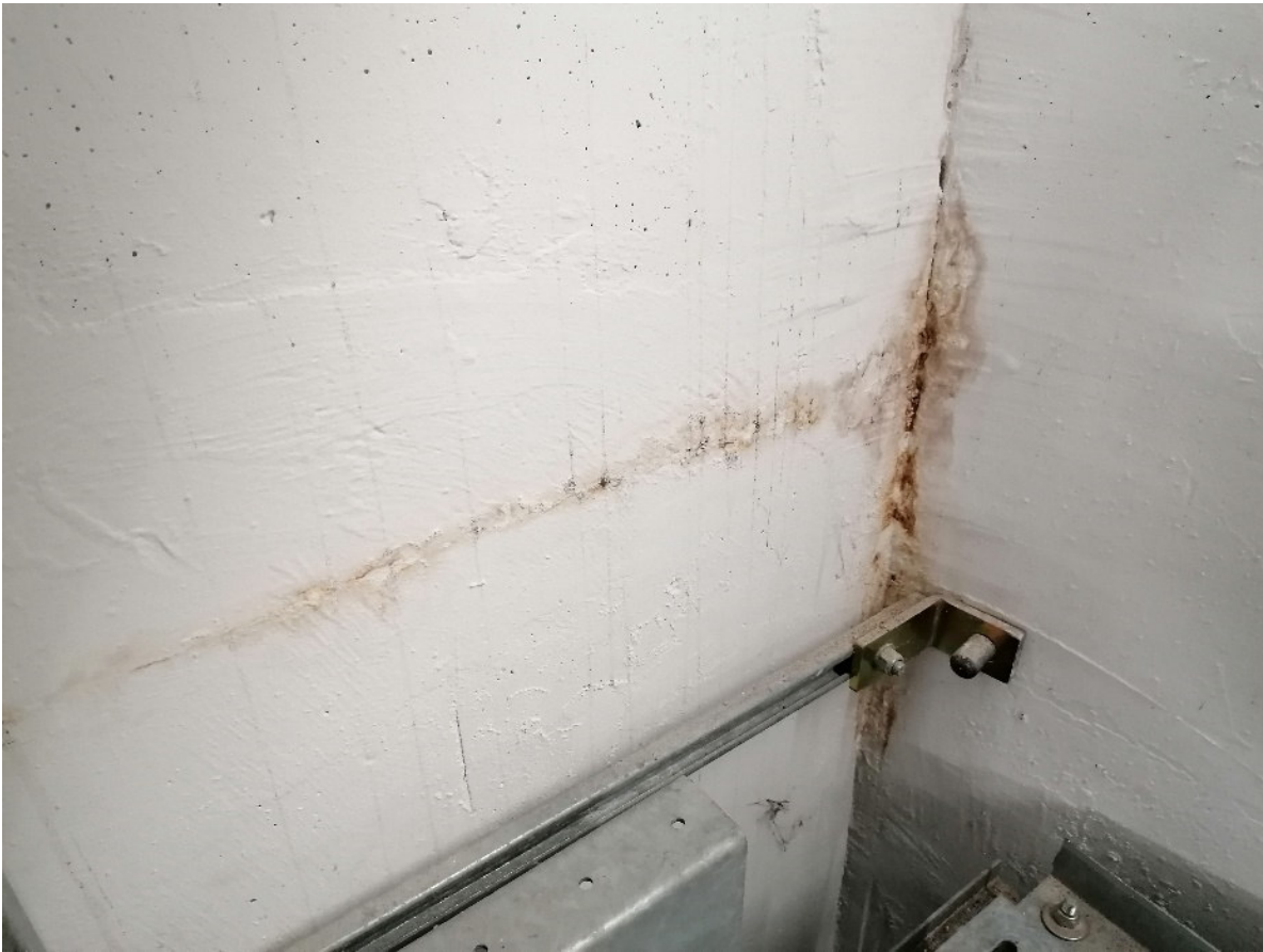
Abb. 6 Feuchteintritte im oberen Eckbereich des Duplexparkers
