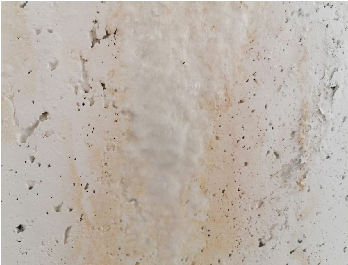
Abb. 4 Nahaufnahme der abgeschlossenen Versinterung am Riss
