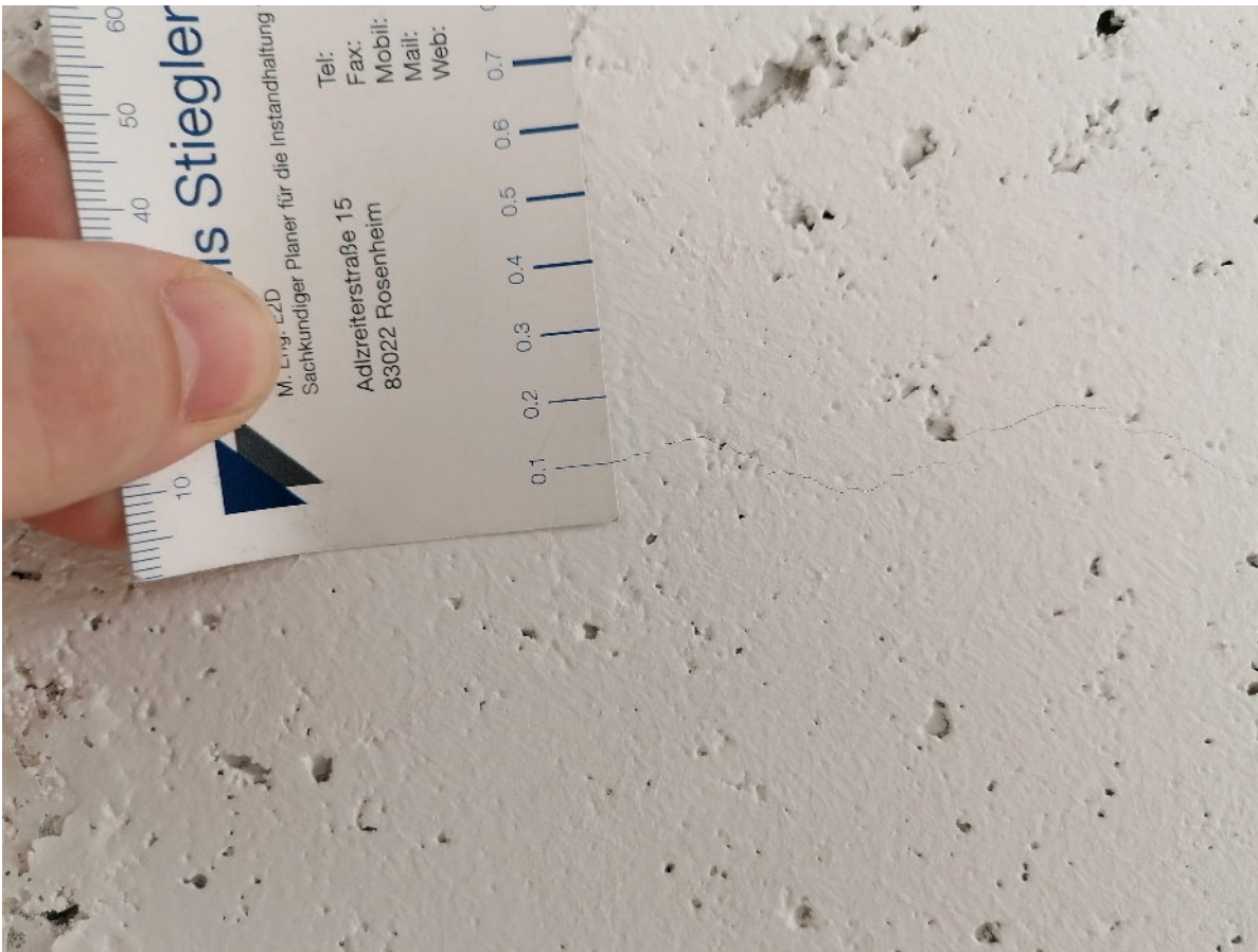
Abb. 5 Rissbreitenerfassung mittels Rissbreitenlineal, Rissbreite > 0,1\text{mm}
