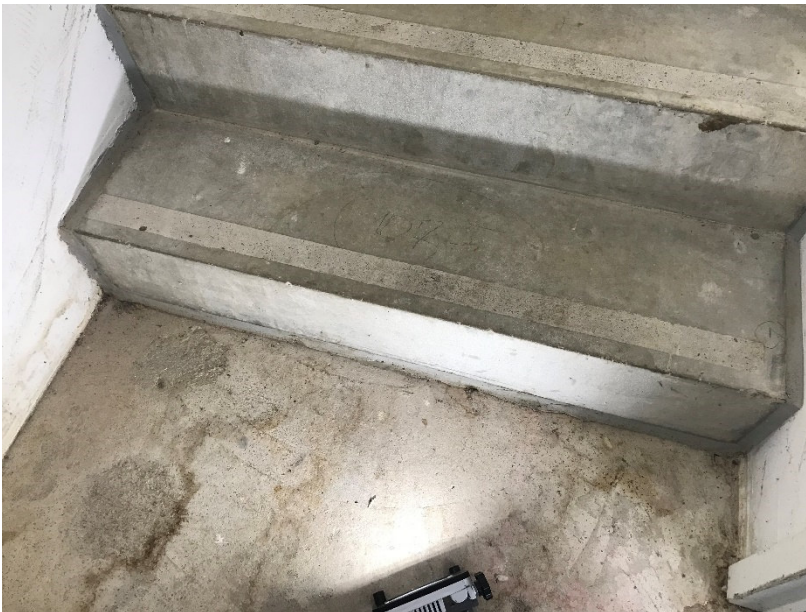
Abb. 24 Fußpunkt der FT-Treppe T12 mit Dichtfuge
