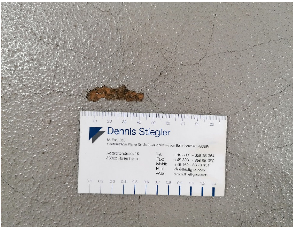
Abb. 42 Abplatzung des Beschichtungssystems im Bereich der Fahrgasse 03.UG
