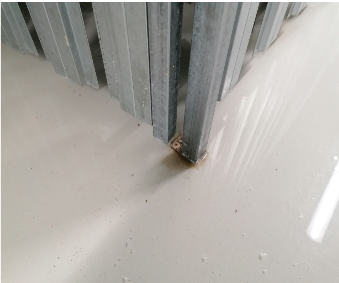
Abb. 22 Verdübelung der Kellerabteil-Trennwände mittig in einer Pfütze ohne angrenzende Rissbildung in der Beschichtung
